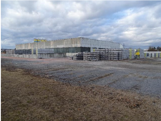
Abb. 4: Blick von Südosten auf das Produktionsgebäude.
