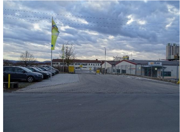
Abb. 5: Blick von Norden auf den Eingang des Firmengeländes.
