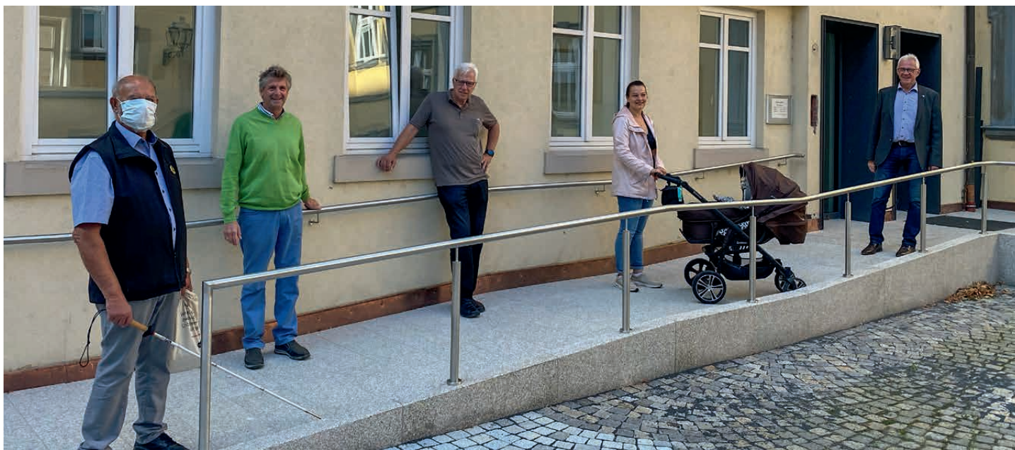
Begehung der barrierefreien Umbauarbeiten im Haßfurter Rathaus
